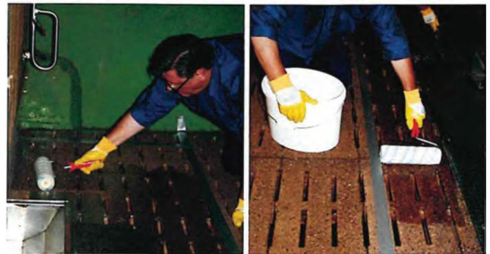
Mit der hochflorigen Rolle (ca. 18 mm) die Epoxiddeckversiegelung AC 130R auf die trockene Grundierung AC 110 aufrollen (Verbrauch: mind. 400 g/m<sup>2</sup> je nach Untergrund, Verarbeitungszeit: ca. 20 Minuten). Die Deckversiegelung AC 130R ist ausgelegt auf hohe rutschhemmende, chemische und mechanische Belastbarkeit. Bis zum Belasten der Fläche sollte ca. 48 Stunden gewartet werden (abhängig von Temperatur und Luftfeuchtigkeit).
